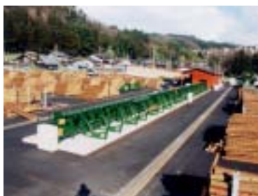
(写真2-1) 石淵貯木所全景
