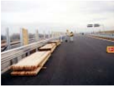
(写真5-13-1) 出荷・納品・設置
