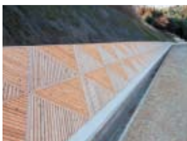
(写真4-1) 法面保護木製パネル
