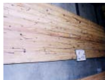
破壊時の亀裂
