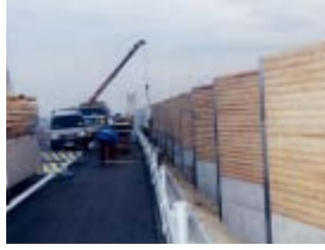
(写真5-13-2) 出荷・納品・設置
