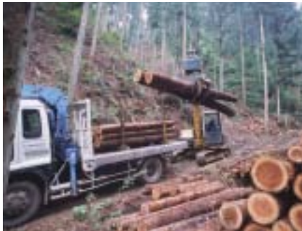
(写真1-6) トラックへ積み込み作業
