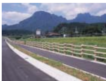
(写真4-2) 3段フェンス
