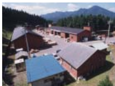
(写真3-1) 加工センター全景
