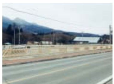
(写真4-3) フェンス国道沿い
