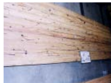
破壊時の亀裂
