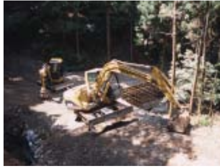
(写真1-2) 作業道開設作業
