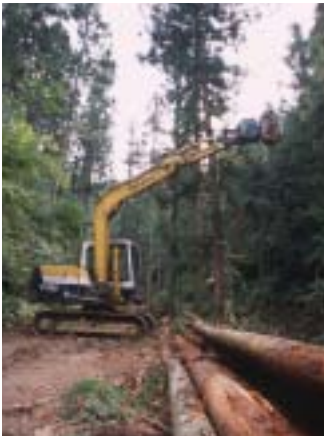
(写真1-3) グラップルによる集材作業
