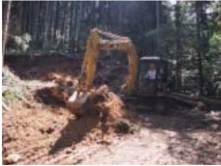
(写真1-1) 作業道開設作業
