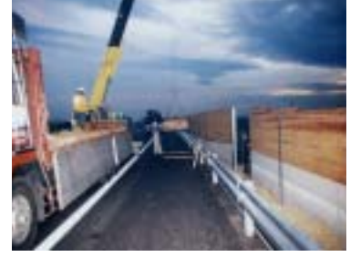
(写真5-13-3) 出荷・納品・設置
