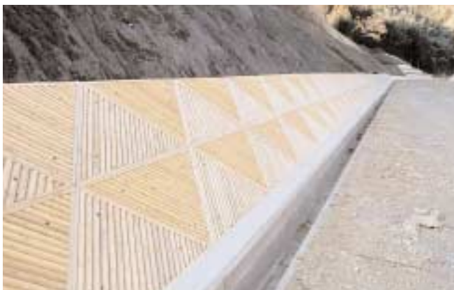
法面パネル（県道）
