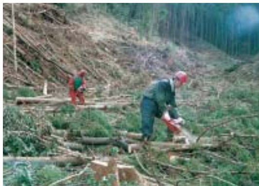
▲伐採作業状況
