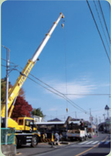
(写真右上) 伐採作業前 (写真右下) 伐採完了 (写真左上) 伐採作業中
